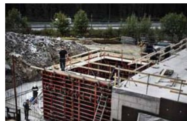
En hel del jobb återstår innan anläggningen är färdig.
